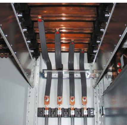
Połączenie: most szynowy z mostem szynowym
